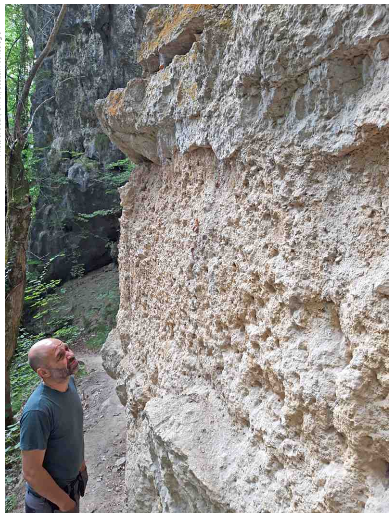
Figure 11. Coupe stratigraphique actuellement visible sous les blocs d'effondrement de la voûte.
