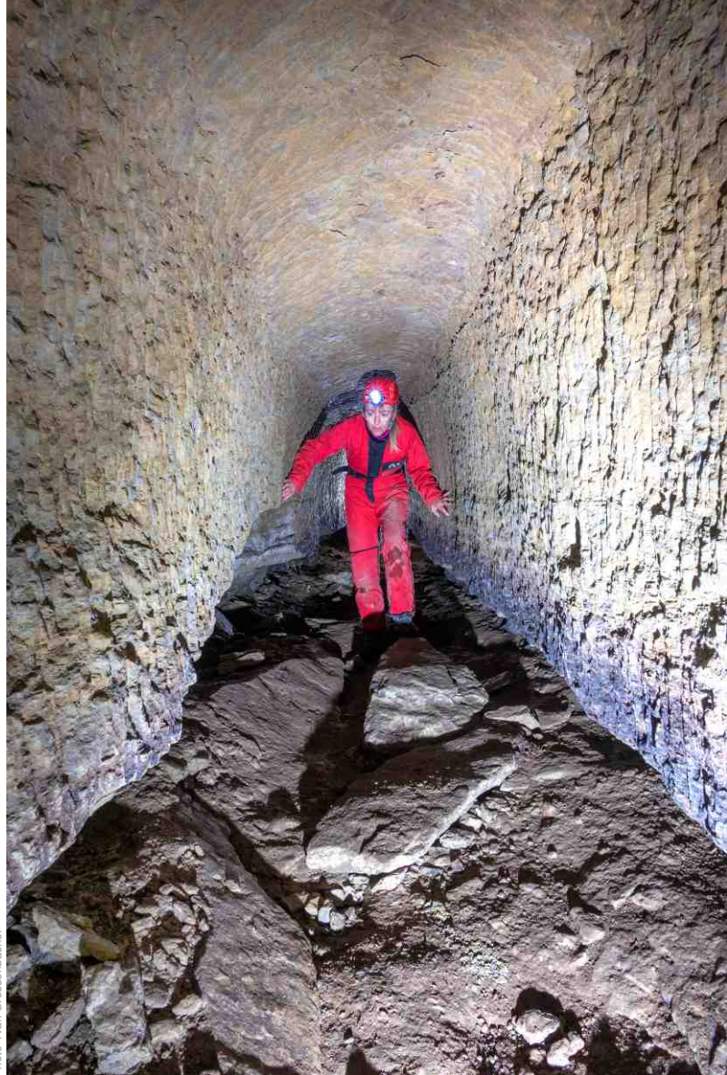
Dans la branche amont de la galerie.
