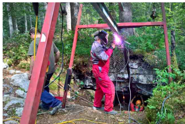
Montage de l'installation.
